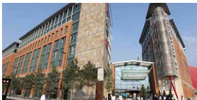
Cloisons et portes - Centre commercial « Le Millénaire » Aubervilliers, France
