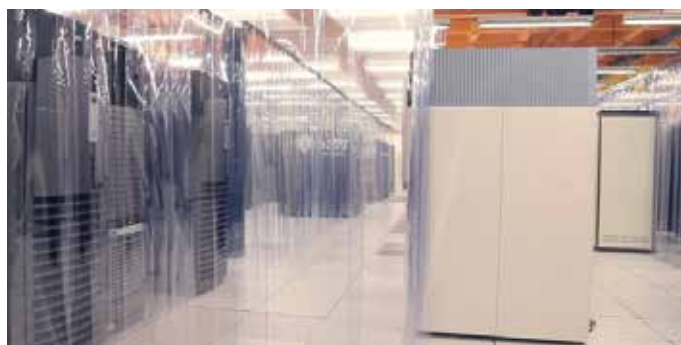
Optimisation énergétique - Datacenter Vodafone France
